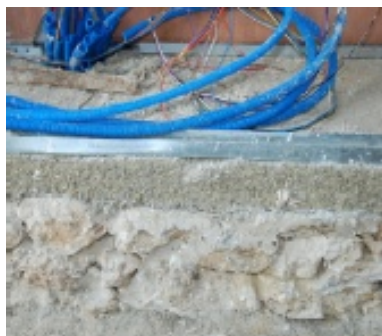
Dalle en béton de chanvre de 15 cm Source : PNR Haute Vallée de Chevreuse
